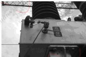
35KV SF6 开关传感器安装
